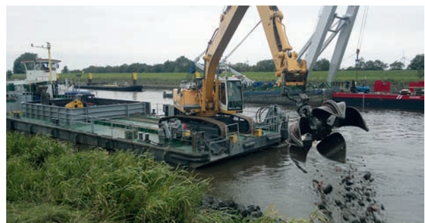
Abb. 13: Instandsetzung Ufer durch HARRIERSAND
