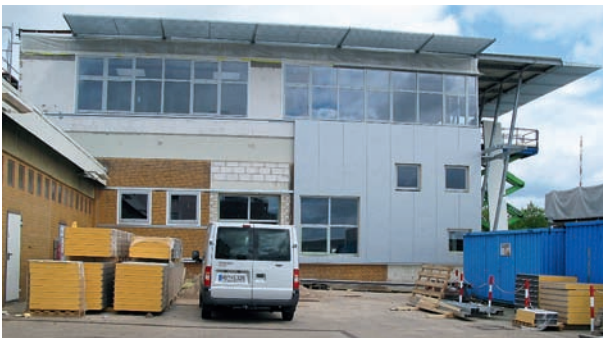
Abb. 5: Mehr Raum für den Nachwuchs: Ein neues Geschoß auf dem ehemaligen Motorenlager entsteht
