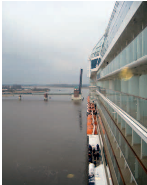
Passage der Jann-Berghaus-Brücke
