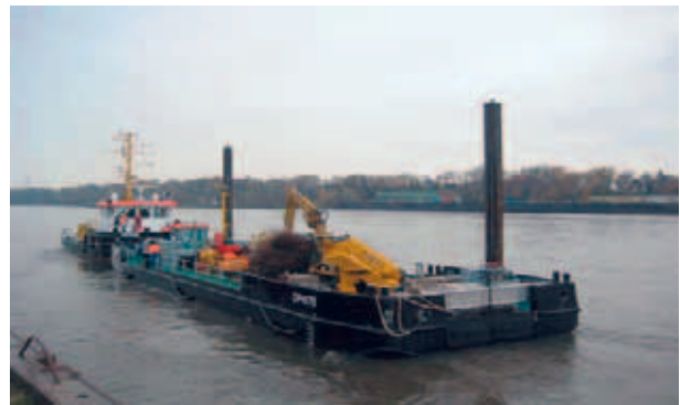
Abb. 10: Geräteeinheit „Ruschsand“ und Decksprahm im Einsatz
