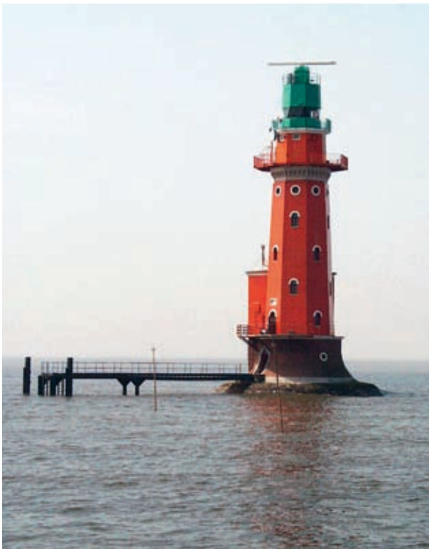
Abb. 1: Vorhandene Infrastruktur wird für die neue Technik genutzt; hier: Leuchtturm Hohe Weg als Verkehrstechnik-Außenstation für mehrere verkehrstechnische Dienste
