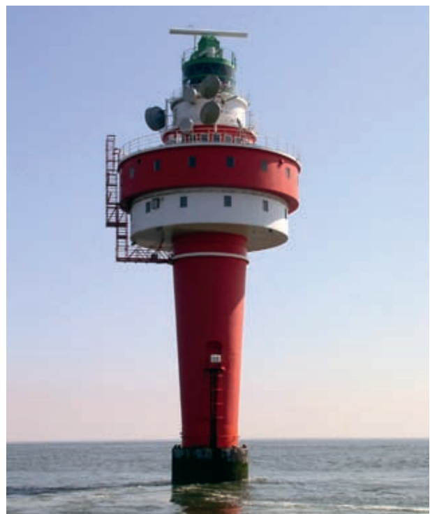
Abb. 2: Richtfunk Alte Weser
