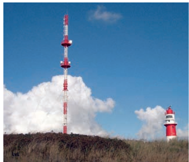
Abb. 3: Richtfunk Leuchtturm – Borkum
