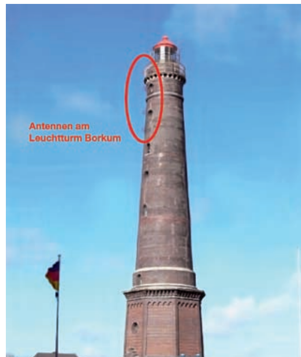
Abb. 5: Verkehrstechnik-Außenstation (VTA) „Großer Leuchtturm Borkum“ mit AIS-Antennen
