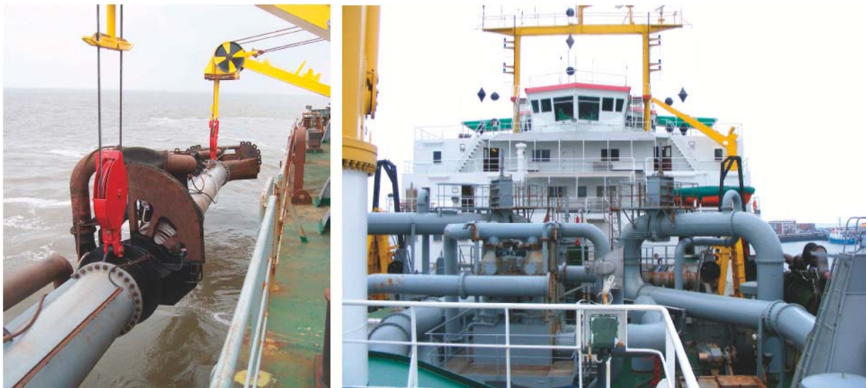
Abb. 3 und 4: Saugrohr und Rohrleitungen
