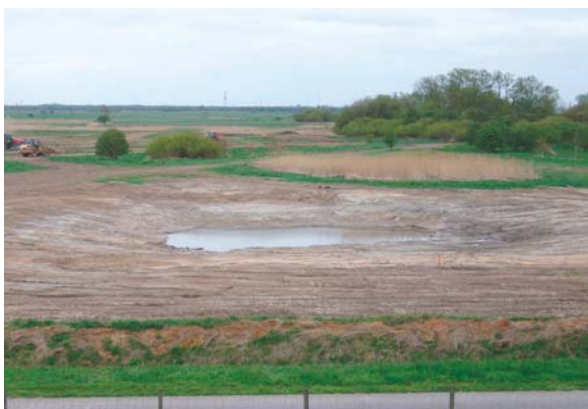
Bild 6: Gewässer nach Fertigstellung im Bereich geschützter Biotope
