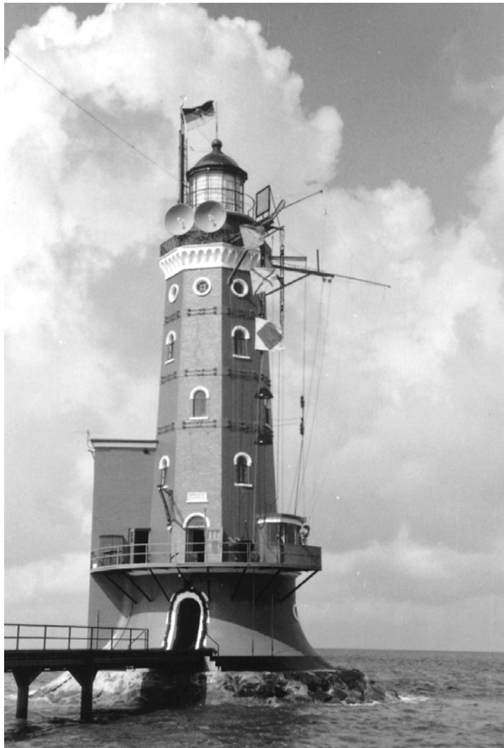
Der Leuchtturm Hohe Weg 1956 an seinem 100sten Geburtstag. Noch vor dem Umbau zur Radarstation, aber schon mit Richtfunkspiegeln für erste Übertragungsversuche von Hochfrequenzwellen
