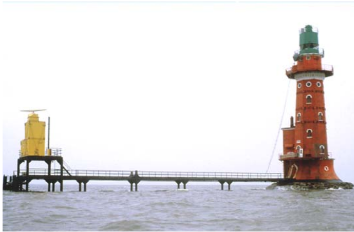
Der Leuchtturm Hohe Weg mit der Hilfsradaranlage während der Umbauphase 1984
