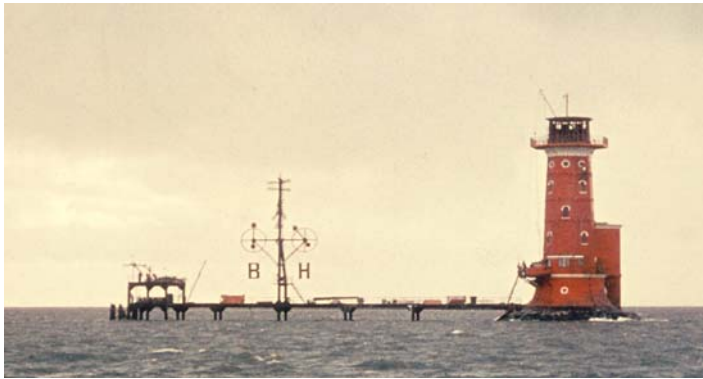
Der Leuchtturm Hohe Weg etwas "kopflös" während der Umbauphase 1960/61
