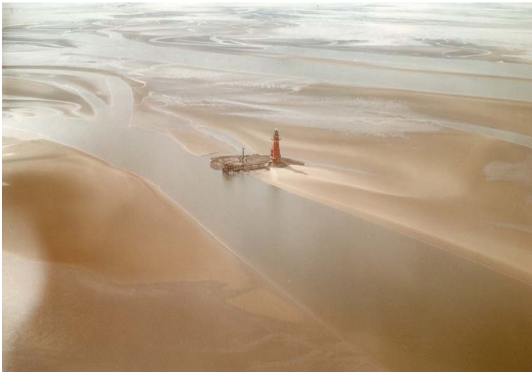
Der Leuchtturm Hohe Weg kurz nach der Automatisierung
