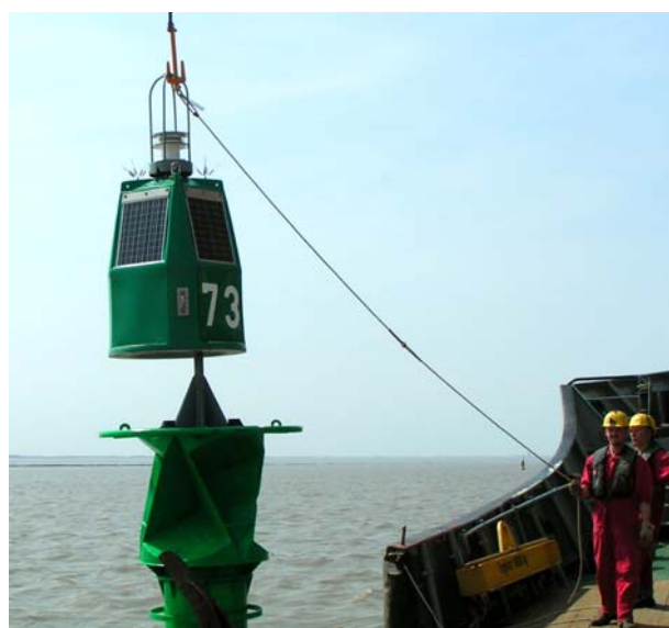
Abb. 18: Montage des SKA mittels Schnellkupplung
