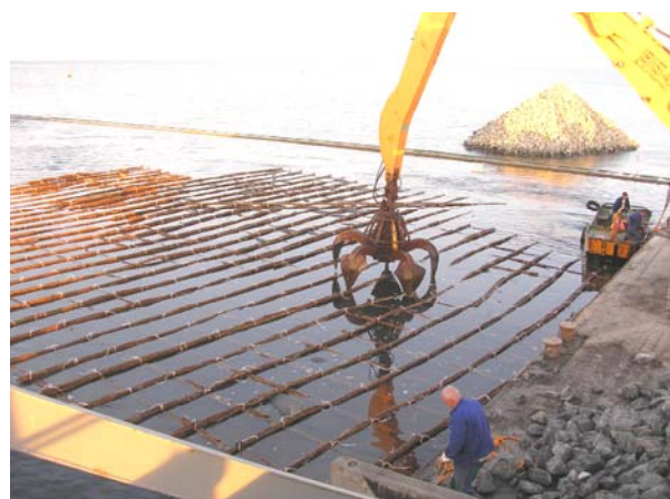
Positionierung der Sinkstücke
