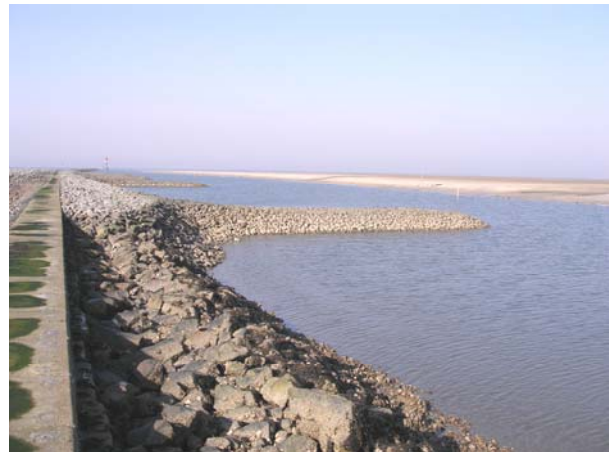
Fertiggestellte Abweiserbuhnen
