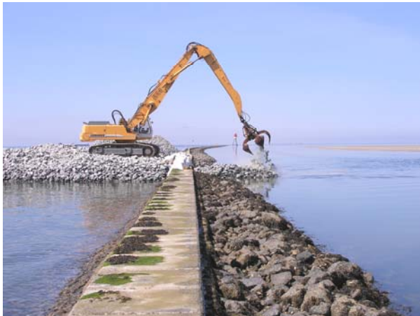
Herstellung der Abweiserbuhnen
