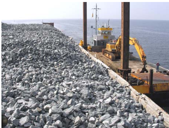
Umschlag von Transportponton auf Arbeitsschiff
