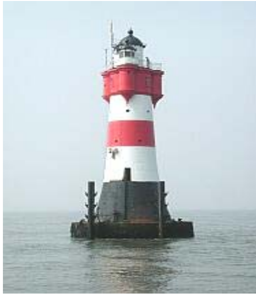
Bild 4: Leuchtturm ROTER SAND
