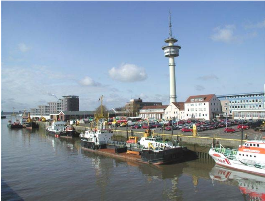
Bild 6: WSA Bremerhaven mit Tonnenhof
