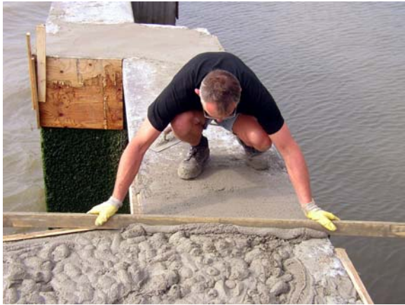
Einbau PCC-Mörtel
