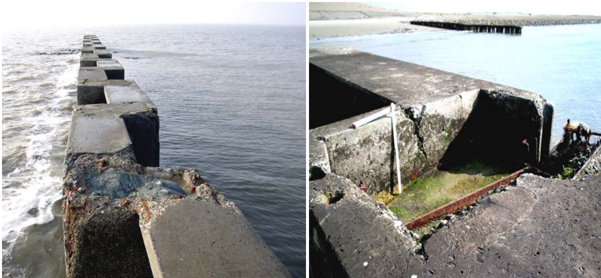
Buhne vor der Instandsetzung
