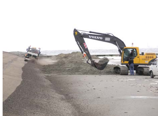
Freilegen und Reinigen der Asphaltoberfläche
