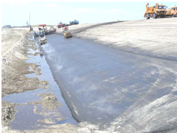
Einbau der unteren 6 m breiten Asphaltbahn
