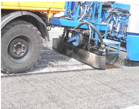
Maschinelles Aufbringen der Versiegelung
