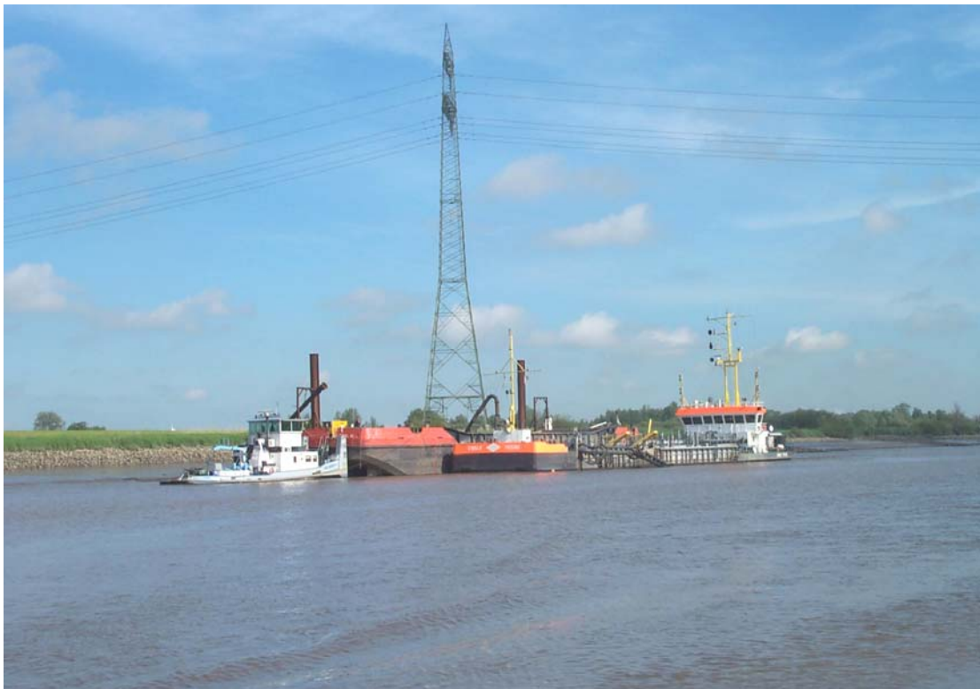
Bild 2: Hopperbagger mit längsseitiger Schute
