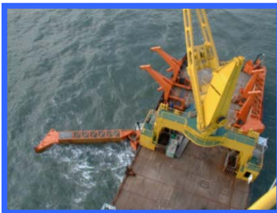
Ein "sweeping arm" ist ausgesetzt
