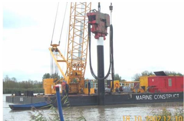
Abb. 5: Einbringen der Führungsdalben
