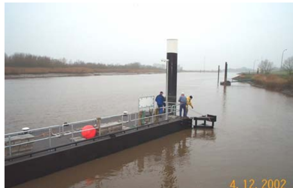
Abb. 10: Festsetzen der Pontons mit den Dalbenschlössern
