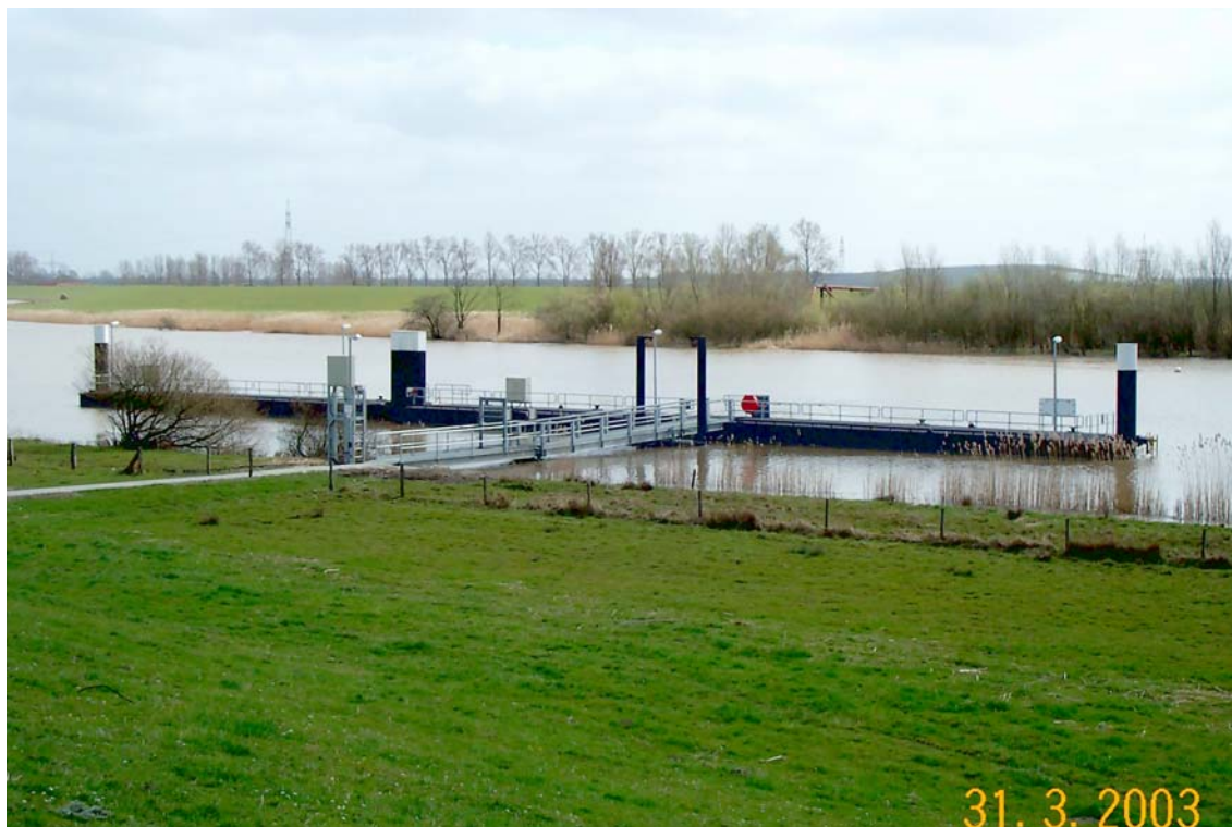
Abb. 11: Fertiggestellte Anlage bei Hochwasser ...
