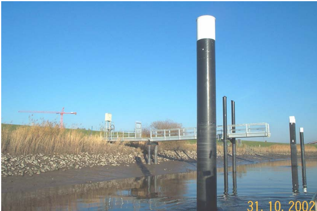
Abb. 6: Ansicht nach Einbau der Dalben und des Zugangsteges
