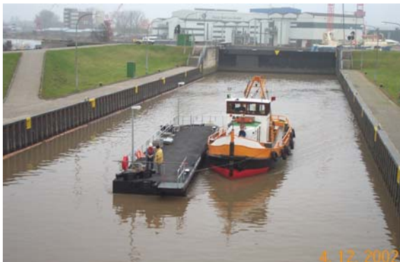
Abb. 9: Transport zur Einbaustelle
