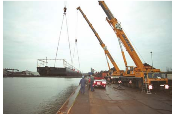
Abb. 8: Hafen Leer: Pontons werden ins Wasser gehoben
