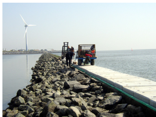
Einbau Betonplatten
