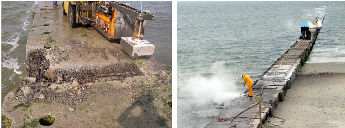
Betonabbruch mit Radlader und Handlanzen
