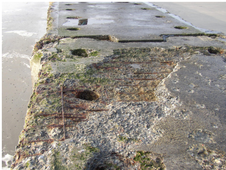
Betonschäden
