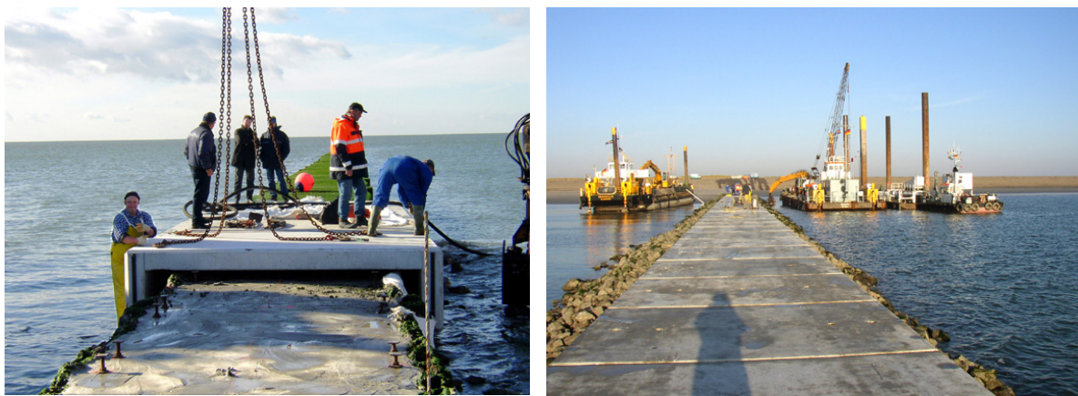
Auflegen der Fertigteile und Ansicht der fertigen Buhne
