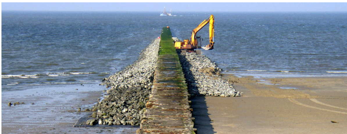
Einbau der Steinschüttung
