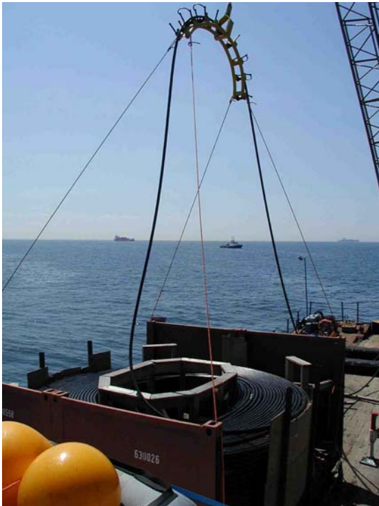
Abb. 10: Kabelentnahme aus dem Kabeltank über die Rollenführung
