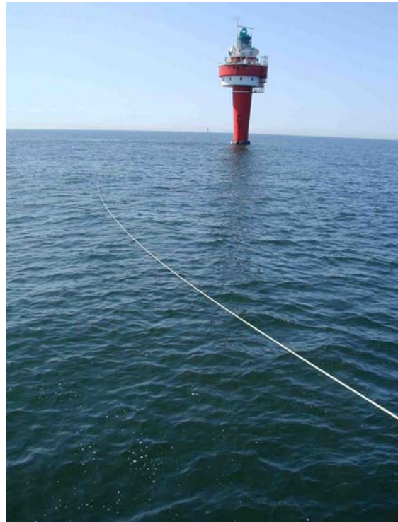
Abb. 11: Zugseil von der Verlegeeinheit zum LT "Alte Weser"
