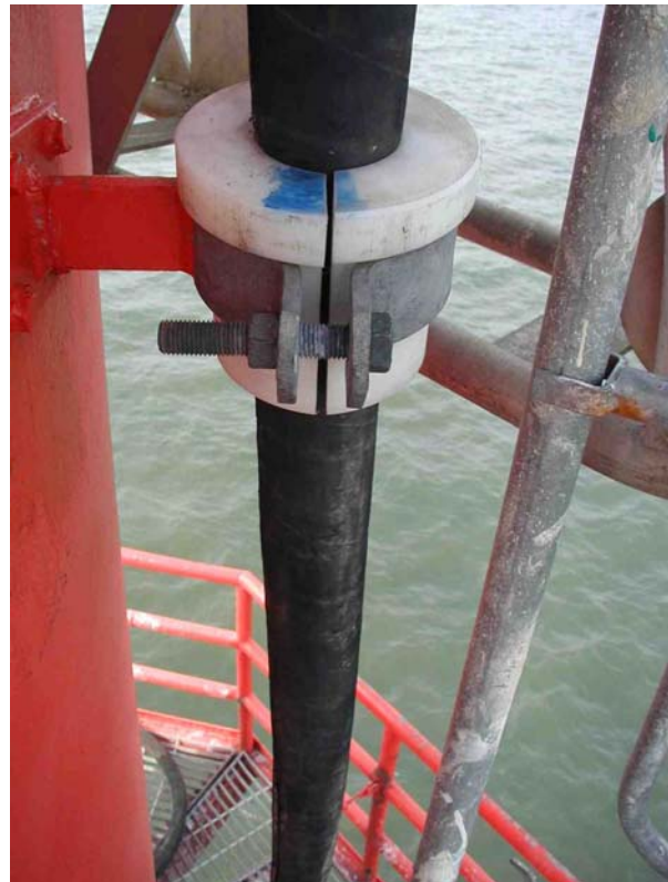
Abb. 14: Das Seekabel wird, umhüllt mit einem längsseits aufgeschnittenen Betonschlauch, über Schellen in die Trazozelle des LT "Tegeler Plate" geführt.
