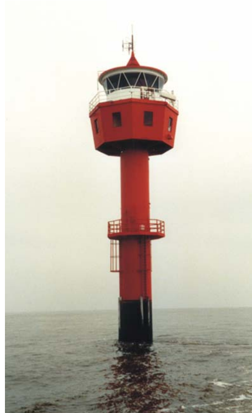
Abb. 3: LT "Tegeler Plate" Der vorgefertigte LT wurde am 14.07.1965 zum Standort geschleppt und eingespült . Fertigstellung 15.07.1965 [2]
