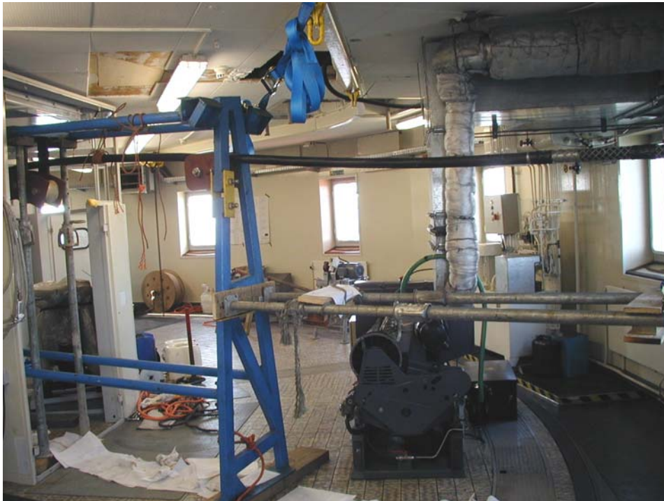
Abb. 8: Das Seekabel ist in den LT "Alte Weser" eingezogen
