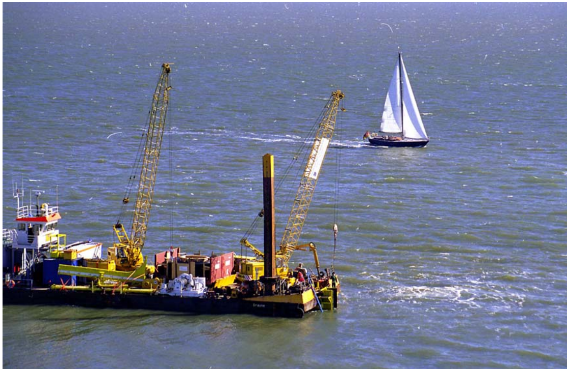
Abb. 6: Das Ende des KSR beim LT "Alte Weser" wurde mit Druckluft gefunden (Blasenbildung)
