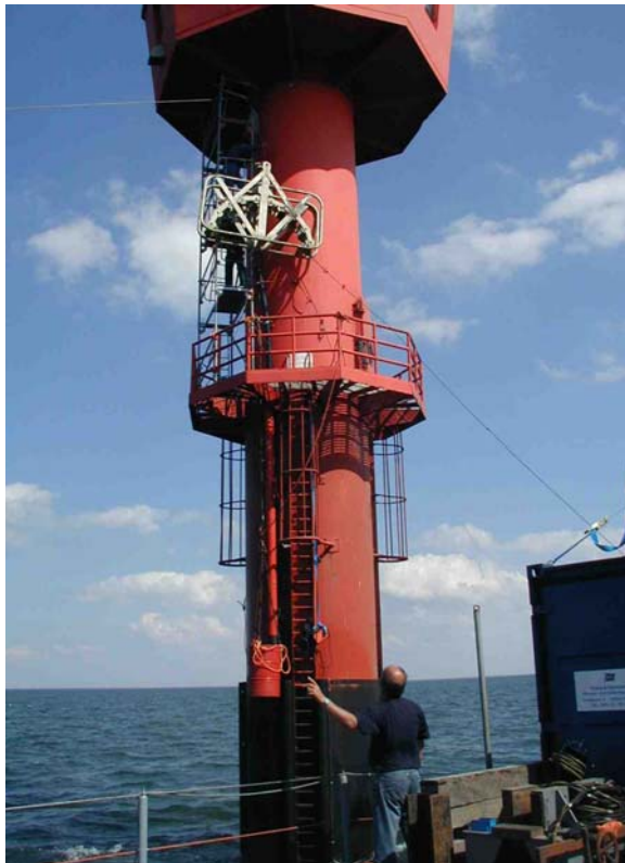
Abb. 13: Einzug des Seekabels in das außen installierte KSR am LT "Tegeler Plate"
