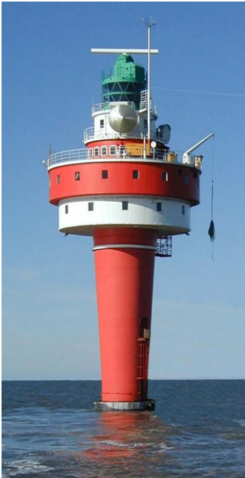
Abb. 2: LT "Alte Weser", Fertigstellung im Rohbau 30.05.1963
