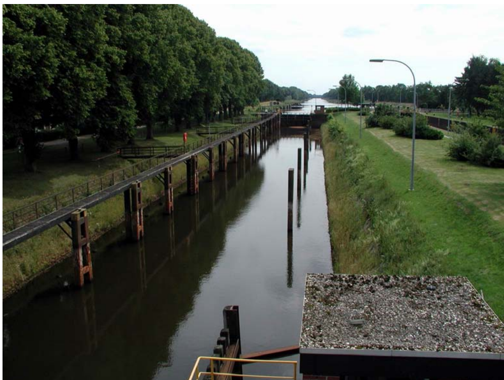
Abb. 4: Die alte Schleuse Dütthe mit geböschter Schleusenkammer
