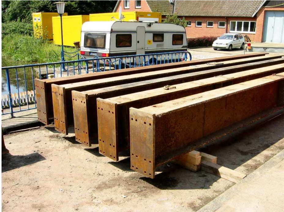
Abb. 4: Errichtung der Baubehelfsbrücke über das Holler Siel
