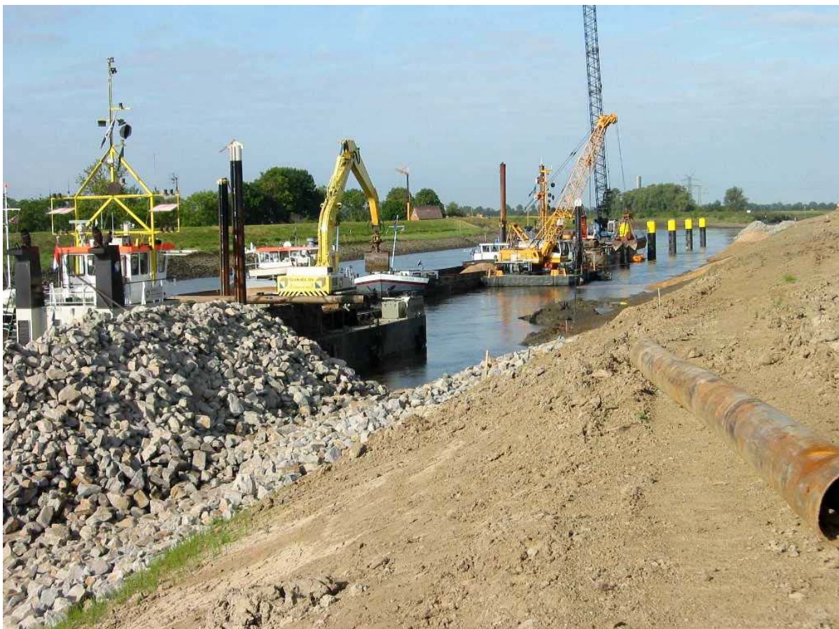
Abb. 8: Deckwerksbau und Einbringen der Dalben in Neuenhuntrorf Nord
