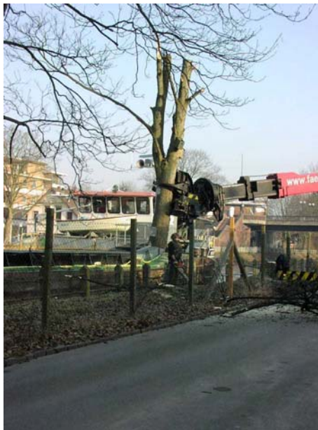
Abb. 2: Baufällarbeiten mittels eines Spezialgerätes aus der Schweiz
