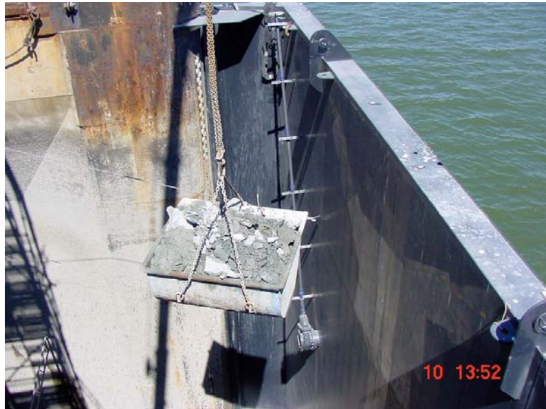
Abb. 6: Abtransport des Abbruchmaterials mittels Kran
