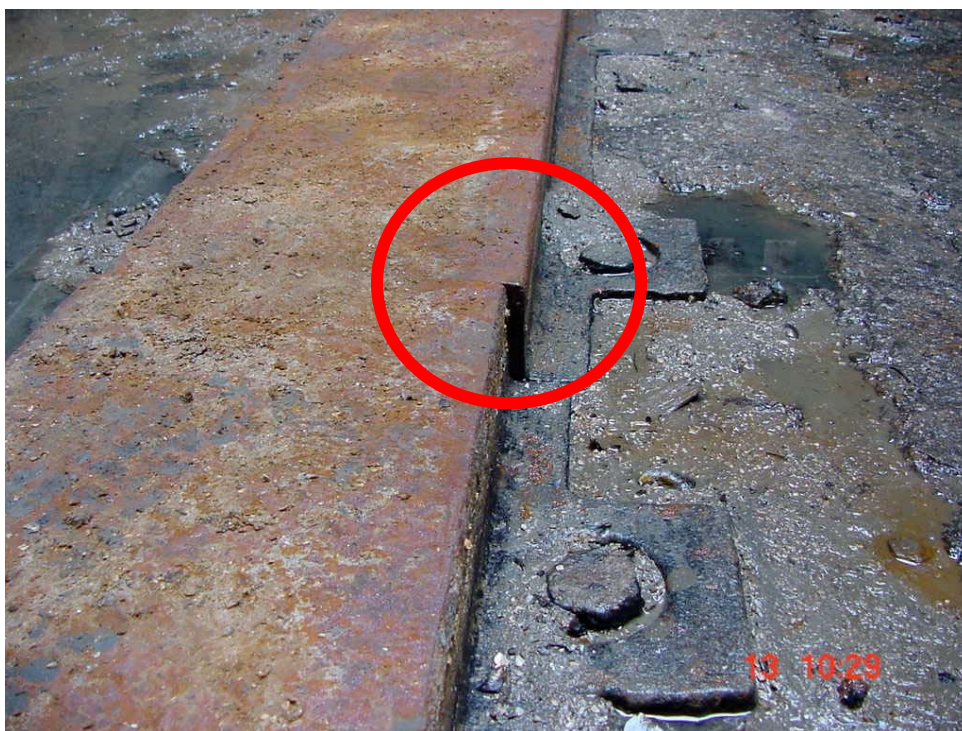
Abb. 4: Versatz an vielen Schienenstößen
