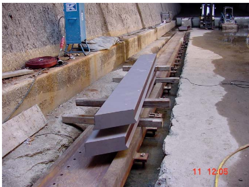
Abb. 8: Eingebaute Grundschiene mit antransportierten Laufschiene
