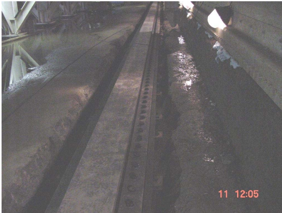
Abb. 9: Eingebaute Laufschiene mit Klemmleiste vor dem Betonieren
