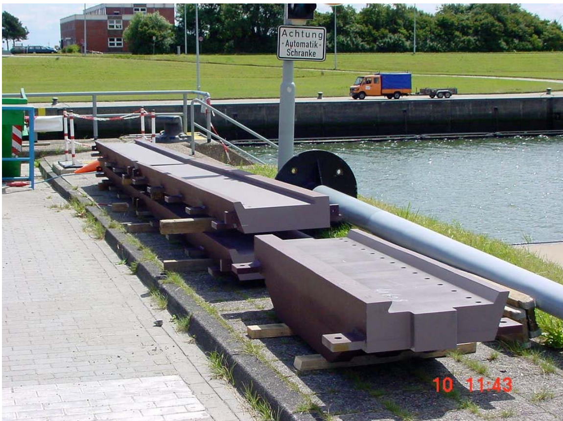
Abb. 7: Antransport der Grundschiene; im Vordergrund als Schienenbrücke
