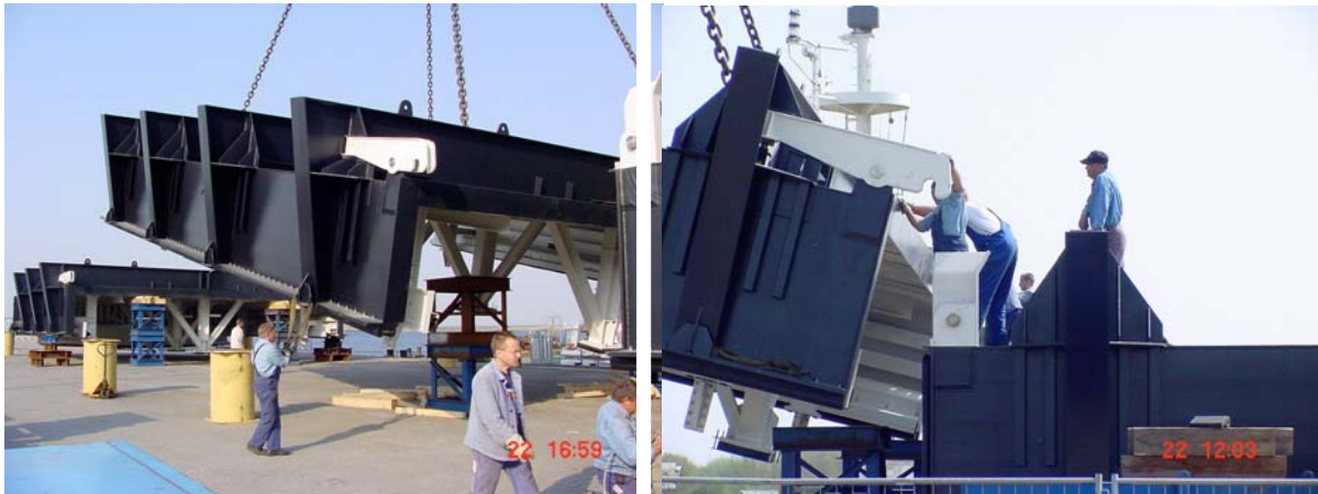
Abb. 6 und 7: Einfädeln des Teiles 4 an Teil 3 beim Probezusammenbau
