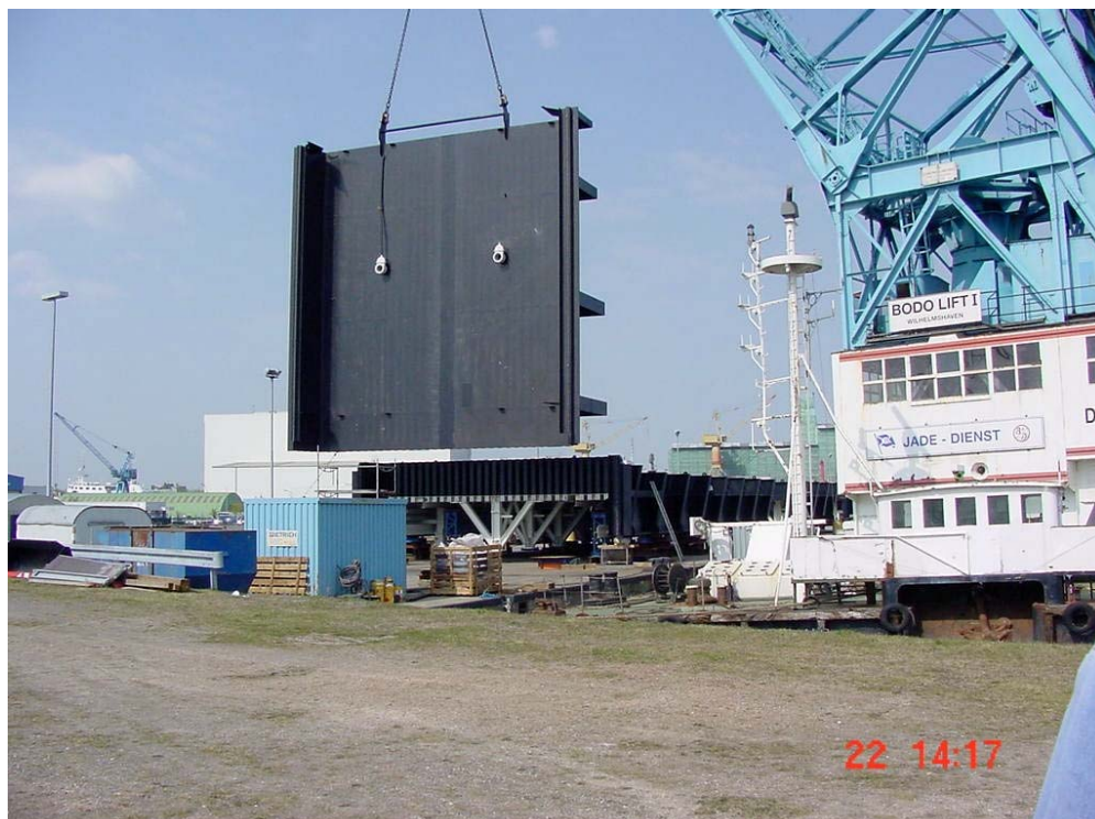
Abb. 8: Setzen des Torkammerverschlusses (Teil 1) auf Teil 2 beim Probezusammenbau
