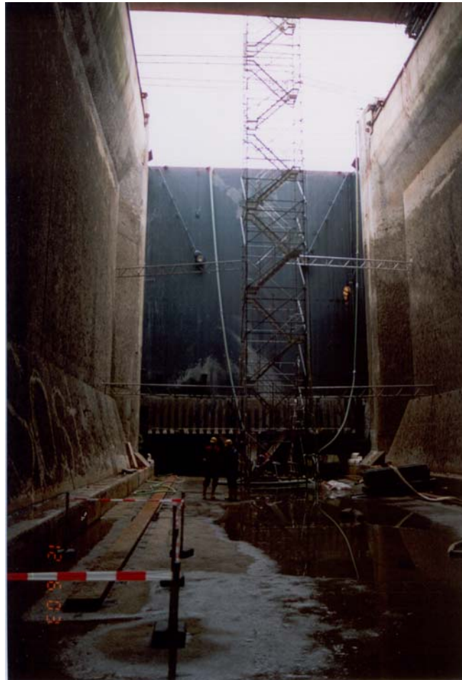
Abb. 10: Blick auf den Drempeltunnel und den 20 m hohen Treppenturm
