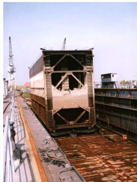
Abb. 2: Schiebetor im Trockendock
