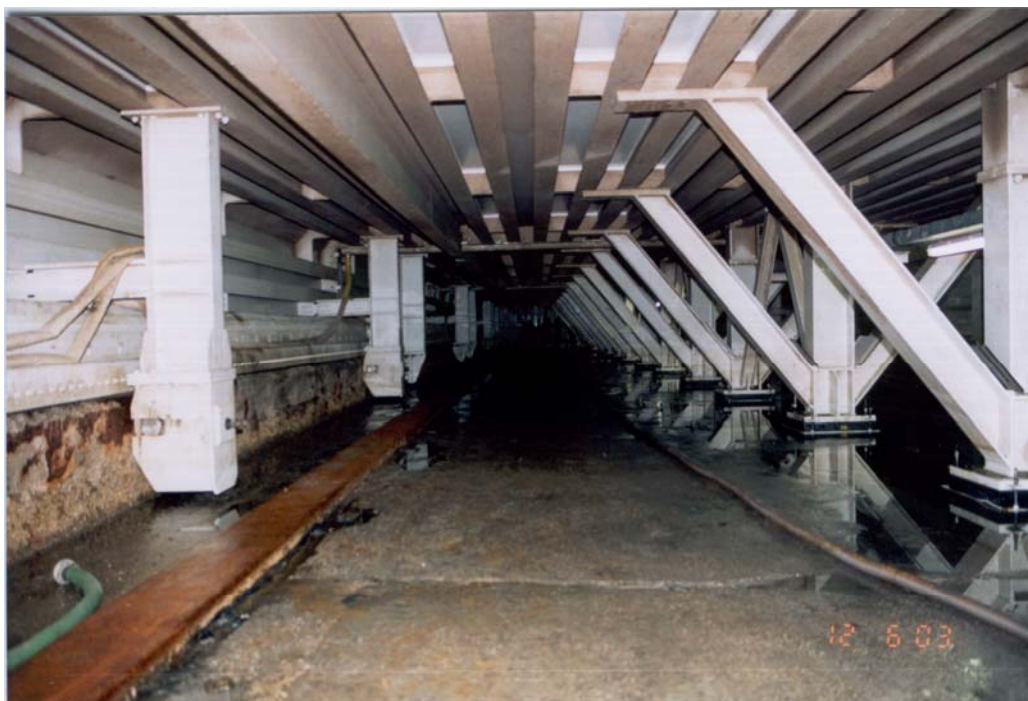
Abb. 11: Blick in die linke Tunnelhälfte
