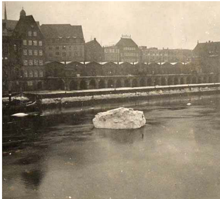
Reste eines Eisversatzes an der "Tiefer" am 14.01.1941 – bei Niedrigwasser –
