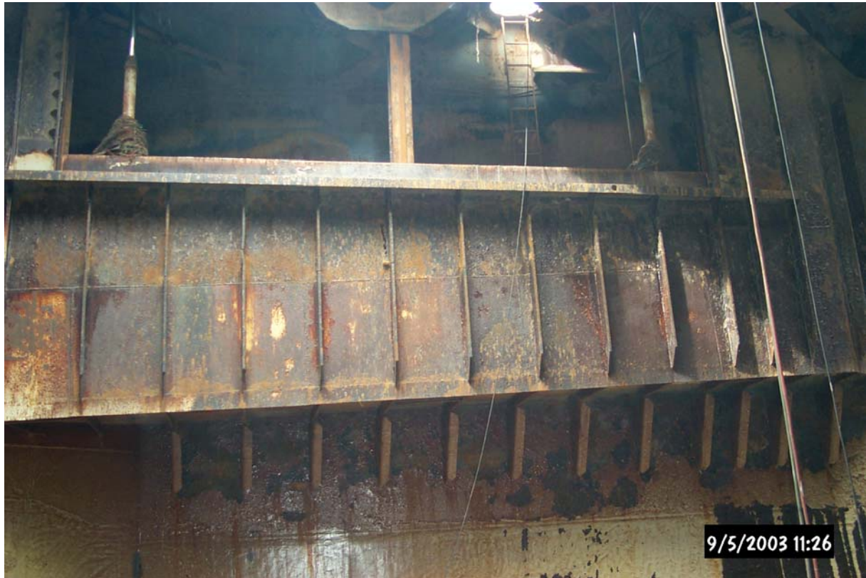
Abb. 5: Eines der alten Überlaufwehre – nach 25 Jahren Einsatz wurde es durch ein neues Überlaufsystem ersetzt
