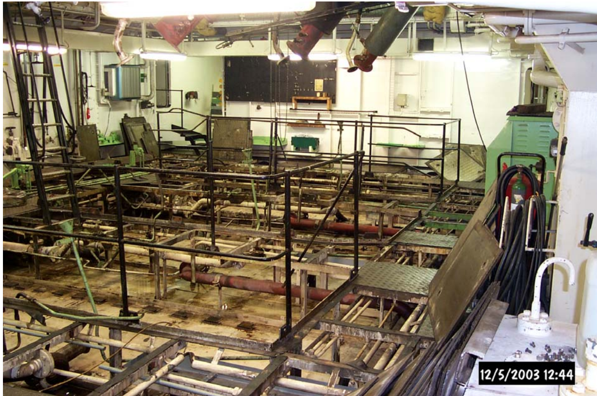
Abb. 3: Blick in den "leeren" Hilfsdieselraum – eine Baustelle !
