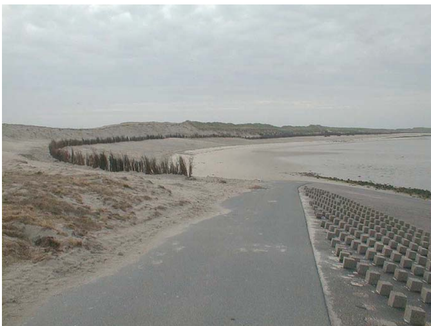
Fertigstellung/Deckwerk unter Sand
