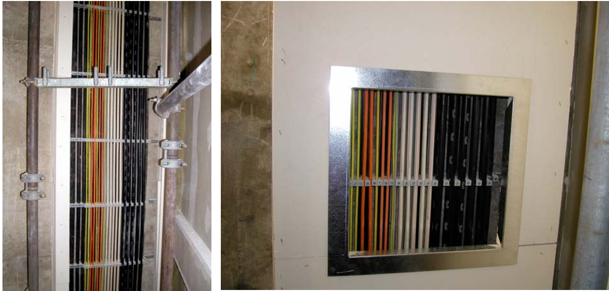
Abb. 4: Noch offene Kabelbahn (links), geschlossene Kabelbahn mit offener Revisionsöffnung (rechts)
