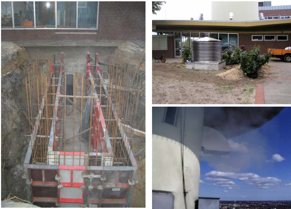
Abb. 3: Ansaugschacht während der Bauphase (links), Ansaughutze (rechts oben) und Ablufthutze (rechts unten)
