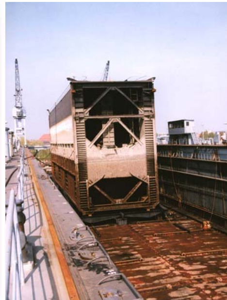
Abb. 2: Schiebetor im Trockendock
