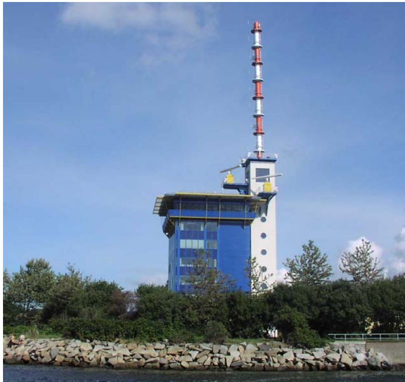
Abb. 2: Verkehrszentrale Warnemünde, Außenansicht
