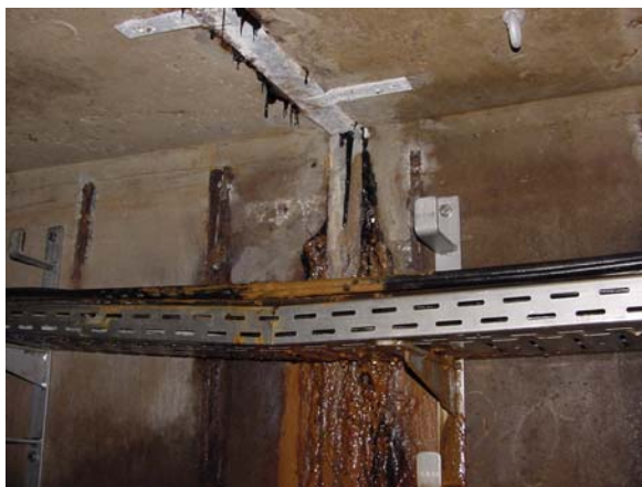
Abb. 2: Austretendes Bitumenmaterial
