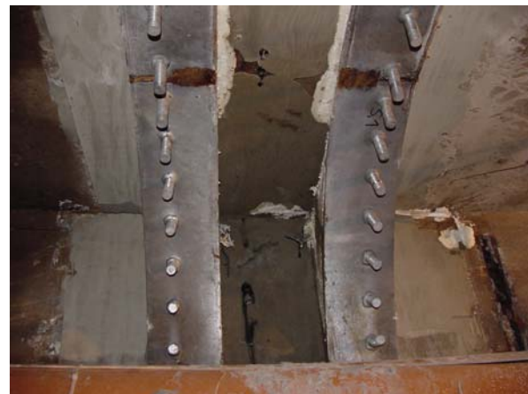
Abb. 14: Ausschaltung nach Verpressung
