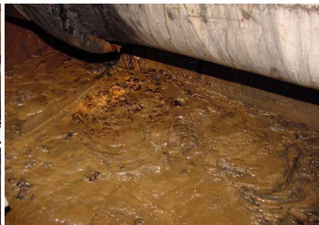
Abb. 3: Austretendes Bitumenmaterial
