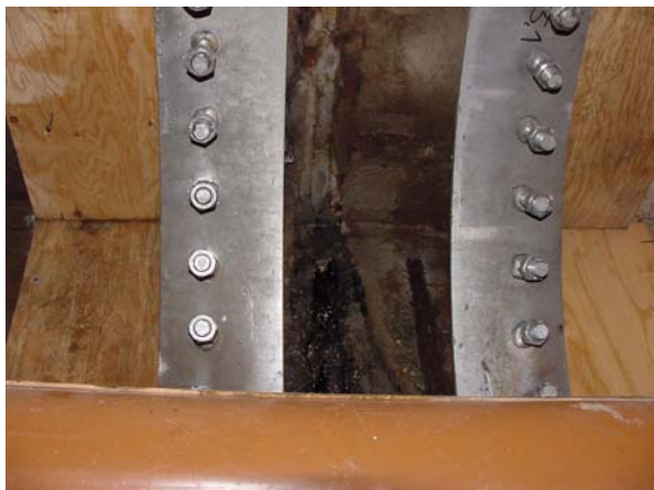
Abb. 13: Einschaltung für Verpressung
