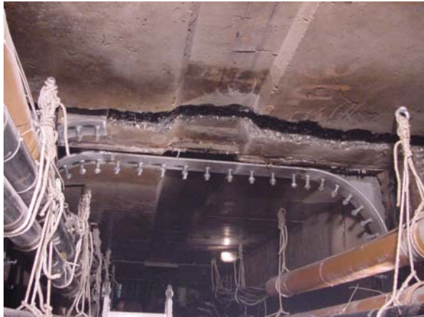
Abb. 11: Eingebaute Stahlbauteil-Unterkonstruktion
