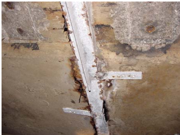
Abb.: 4: Stahlaschenabdeckung
