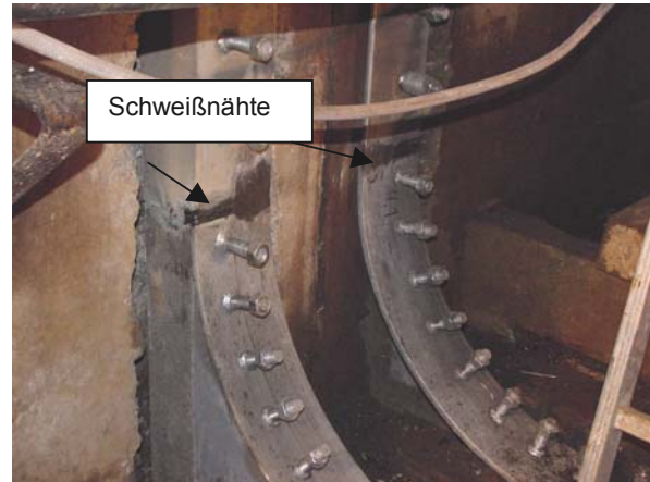
Abb. 12: Schweißnähte
