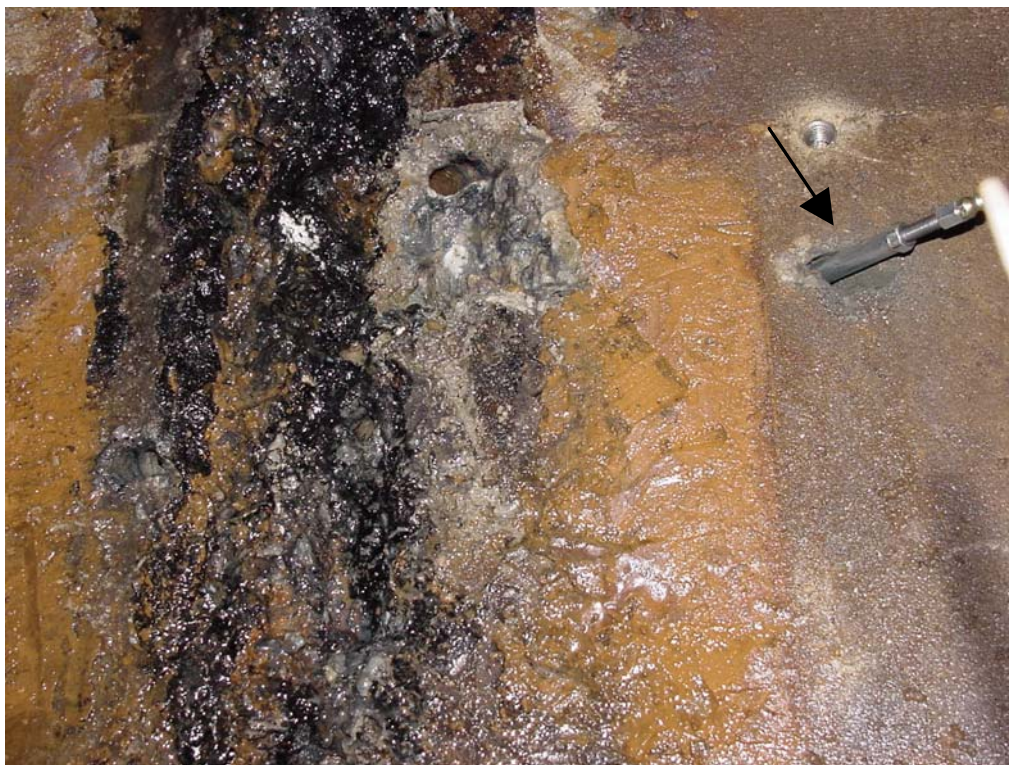
Abb. 6: Schraubpacker
